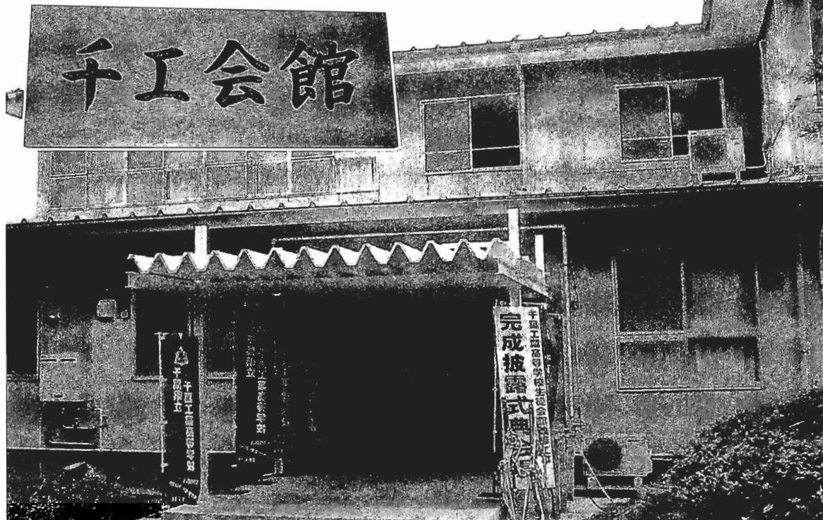
改修工事が完了した「千工会館」と看板
