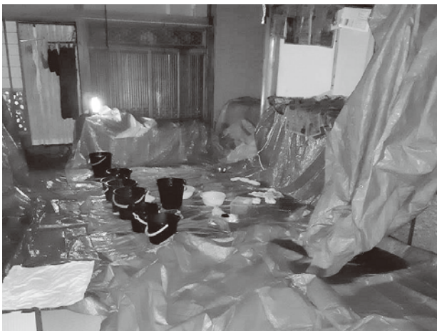
雨漏りをブルーシートでしのぐ
