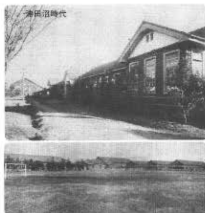
昭和20年7月7日の空襲で校舎を失ったから、 稲毛の日本ハルプ工場で授業が行われたが、 昭和21年1月に元鉄道第一連隊材料廠倉庫跡 に移転。 23年4月には千葉工業高等学校と改称した。
