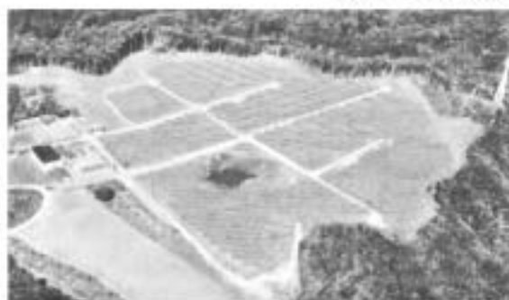
平岡牧場の発電設備
